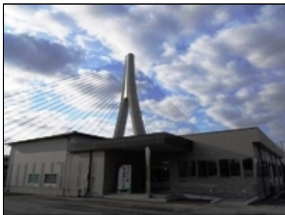
新今区民会館竣工
